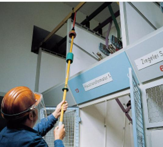
Feststellen der Spannungsfreiheit an einer Sammelschiene einer Mittelspannungsanlage
