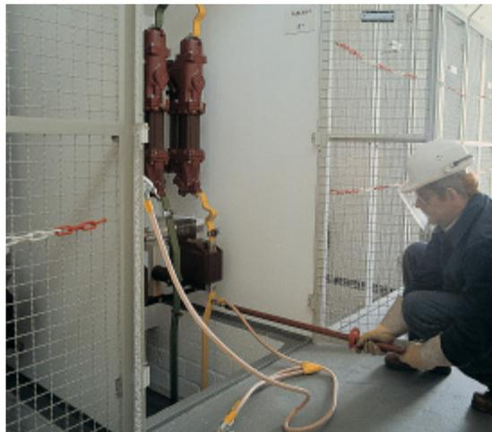
Die Erdungs- und KurzschlieÙvorrichtung ist immer zuerst mit der Erdungsanlage zu verbinden
