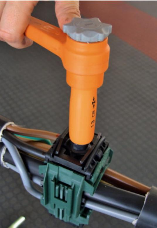
Berührungsgeschützte Klemmringe verkürzen nicht nur die Montagezeit für die Erstellung eines Abzweiges, sondern ermöglichen auch die Montage ohne Verwendung von PSA gegen elektrische Gefährdungen.
