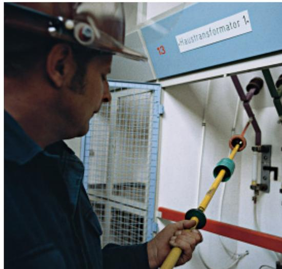
In Schaltzellen kann nur ein normgerechter Spannungsprüfer eine eindeutige Aussage über den Spannungszustand geben
