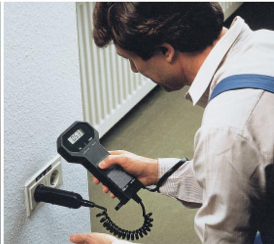
Prüfung der Schutzmaßnahme eines Steckdosenstromkreises
