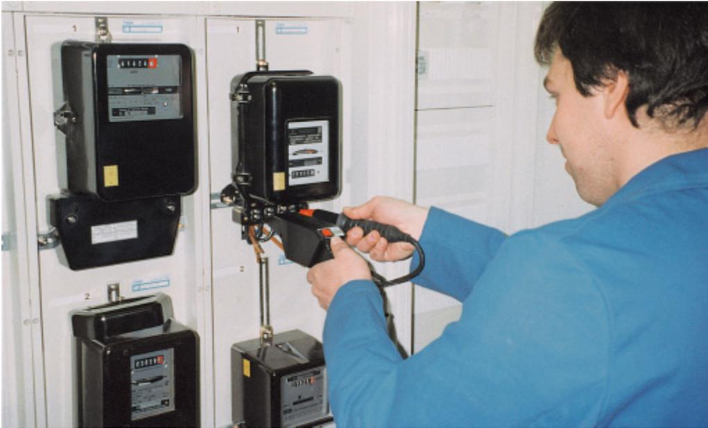
Zähleranlaufprüfung an einem Drehstromzähler
