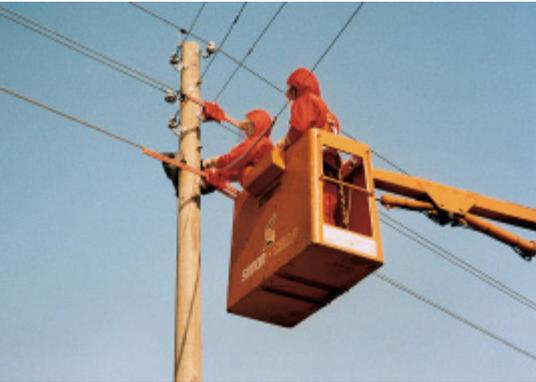
Arbeiten unter Spannung an einer Niederspannungsfreileitung
